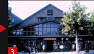
3 旧木村倉庫(北一硝子三号館) 海産物業などで成功した木村円吉が明治24年に建設。荷物の運搬に使われたトロッキのレールがいまも残る。
