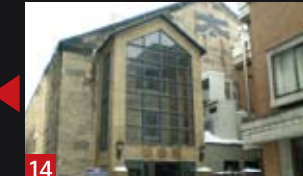
14 旧高橋倉庫 小豆將軍の異名をとり、ロンドンの相場も動かしたといわれる高橋直治が、大正12年に倉庫として建設。
