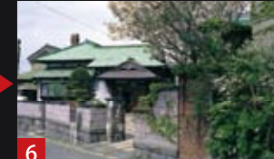
6 旧寿原邸 大正1年建設。小樽を代表する実業家寿原家の邸宅。水天宮の北側、急な傾斜地に建てられ、主屋から上手に2つの接客棟を連ねています。
