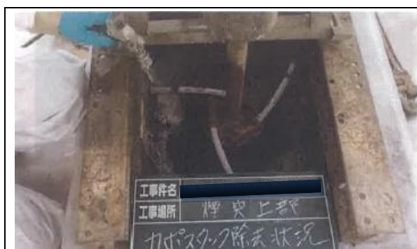
断熱材の除去工事
