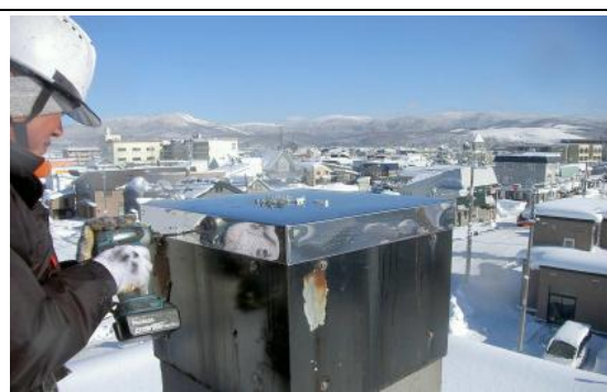
煙突用断熱材の囲い込み例
