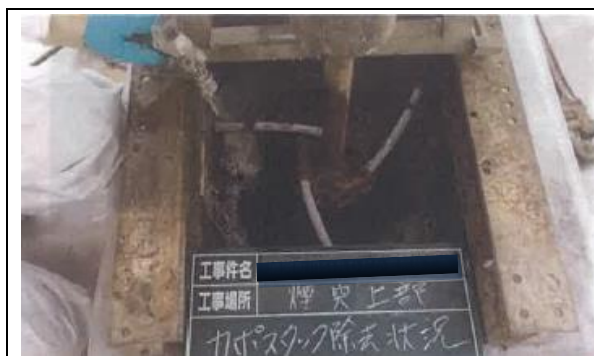
断熱材の除去工事
