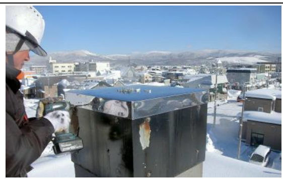
煙突用断熱材の囲い込み例
