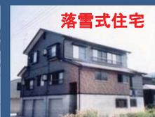
フッ素加工の屋根にあわせて高床式化した自然落雪構造住宅
