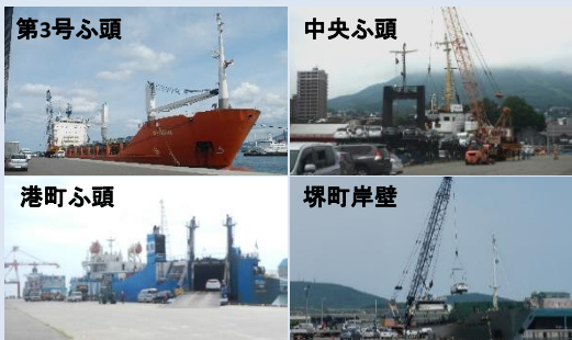
各ふ頭に分散して荷役を行っているロシア船
