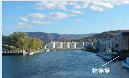
老朽化が進んでいる物揚場
