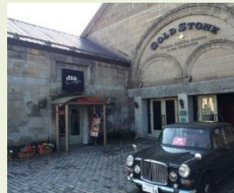
石造り倉庫 → カフェ、イベントスペース
