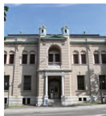
日本銀行舊小樽支店（金融資料館）
