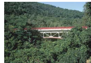
⑦張碓川とアーチ橋
