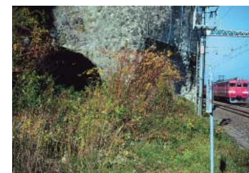
④義経トンネルと煉瓦の橋
