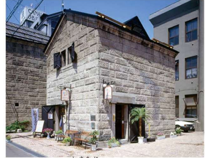
第42号 旧嶋谷倉庫 ①色内1-2-18②M25③木骨石造1階④H5.11.24
