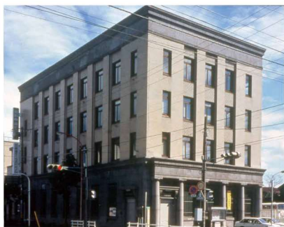
第18号 旧三菱銀行小樽支店 ①色内1-1-12②T11③鉄筋コンクリート造4階④H2.7.5
