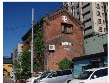
第83号 旧磯野支店倉庫 ①色内2-2-14②M39③煉瓦造2階④H28.7.25
