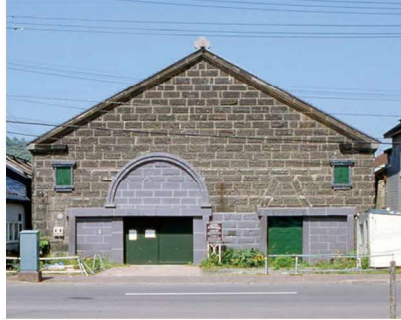
第22号 旧増田倉庫 ①色内3-10-19②M36③木骨石造2階④H3.7.17
