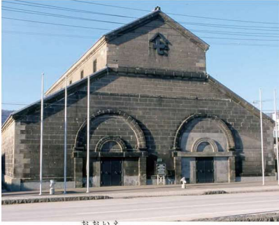
第1号 旧大家倉庫 ①色内2-3-11②M24③木骨石造1階④S.60.7.23
