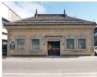
第9号 旧第百十三国立銀行小樽支店 ①堺町1-20②M28③木骨石造1階④S60.7.23
