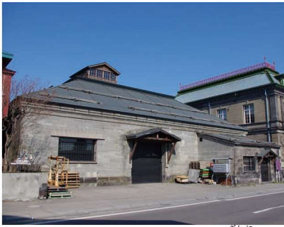
第54号 旧日本郵船(株)小樽支店残荷倉庫 ①色内3-7-6②M39③石造1階④H6.5.12
