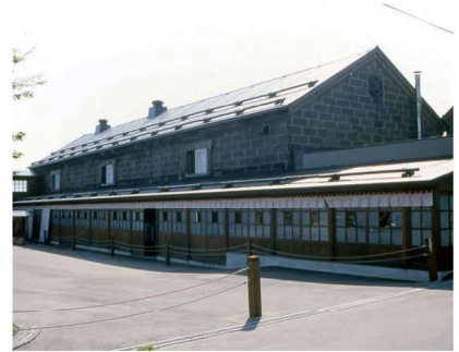
第64号 旧岡崎倉庫 ①1号棟:信香町2-2/2・3号棟:信香町2-24 ②1号棟:M38/2・3号棟:M39 ③木骨石造1階一部2階④H8.3.27
