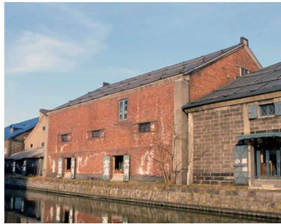
第63号 旧篠田倉庫 ①港町5-4②T14③木骨煉瓦造2階④H7.11.1
