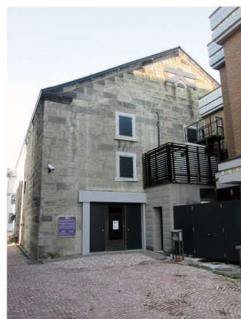
第51号 旧高橋倉庫 ①色内1-2-17②T12③木骨石造2階④H6.5.12
