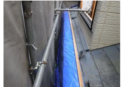
①屋根にシート掛けし、上から角材で押さえ釘で固定する。
