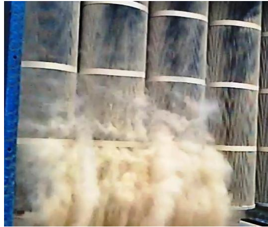
写真Ⅲ-3 フィルタ自動再生状況
