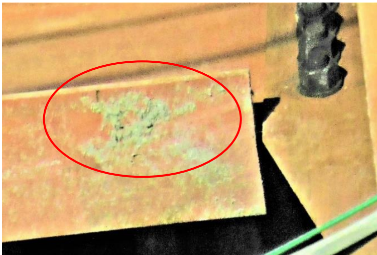
鉄骨梁下の取り残し
