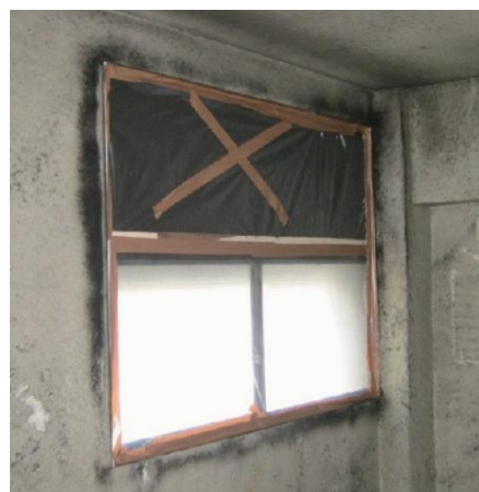
図 4.7.14 窓、換気口の負圧隔離養生例
