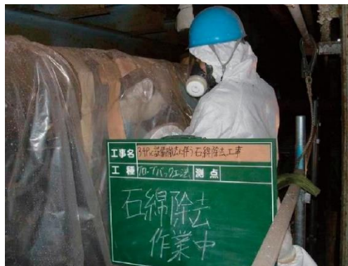
図 4.10.9 石綿除去作業中 1
