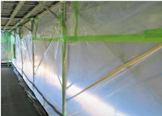
周囲への飛沫飛散防止養生例（内部）
