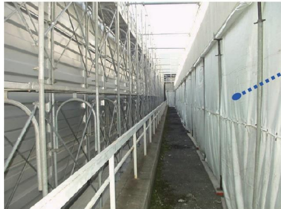
図 4.7.19 外壁開口部の飛散防止措置（開口部全面に防炎シートを張った）
