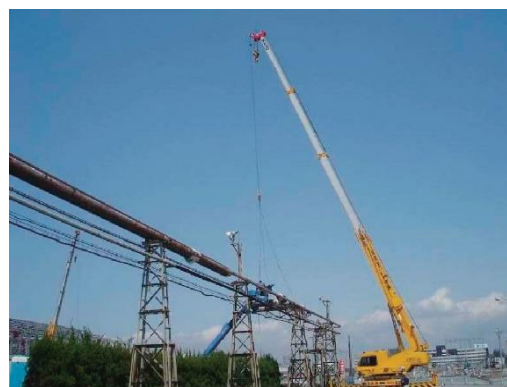
図 4.10.5 配管の吊り下ろし
