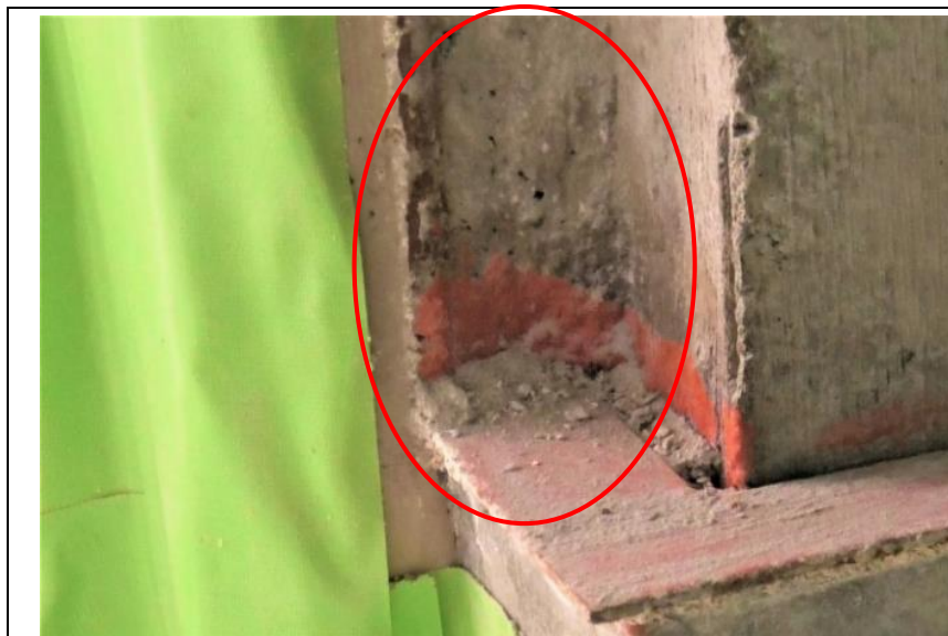
腰壁入隅部の清掃不良
