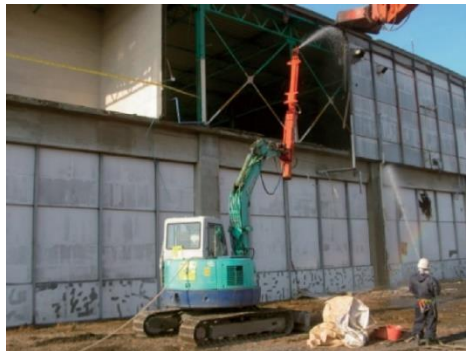
図4.11.5 湿潤化の例 （作業内容に応じて立入禁止措置や掲示を行うこと）
