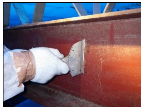
図4.15.5 再付着した石綿の除去
