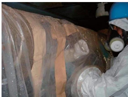
図 4.10.10 石綿除去作業中 2
