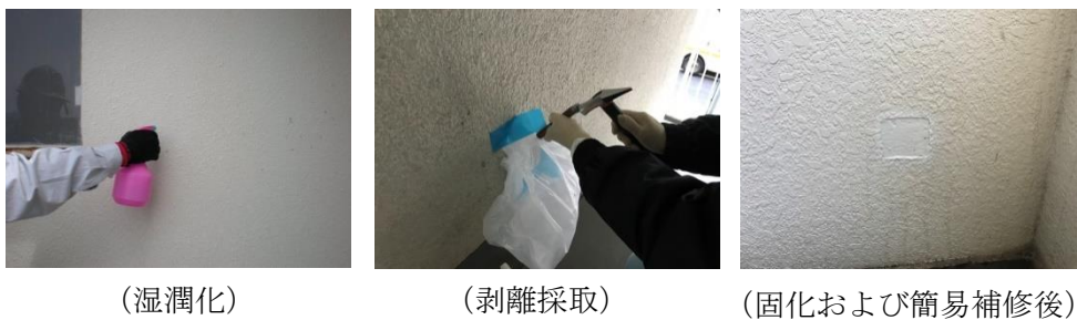
図 I - 5 - 9 サンプルング例 (建築用仕上塗材等)
