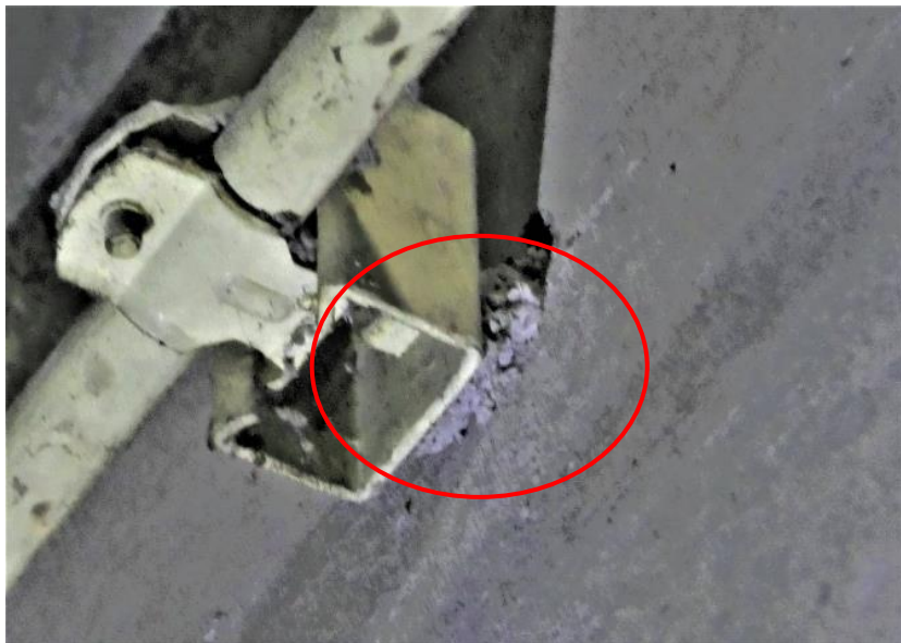
電線管ダクター部の清掃不良
