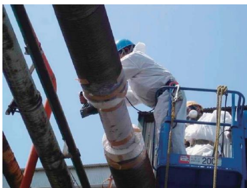
図 4.10.4 切断箇所の保温材除去と養生
