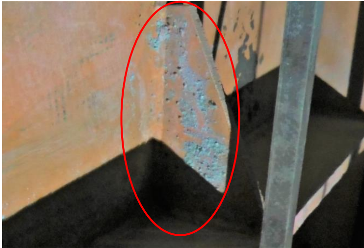
鉄骨梁側面の取り残し
