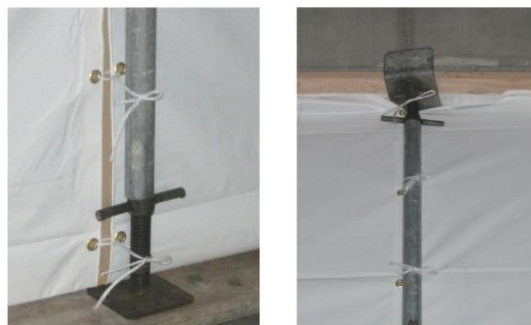
図 4.7.20 防炎シートの固定詳細（左：足元。単管にベースジャッキを挿入。右：頭部。単管に根太受け金物を挿入）
