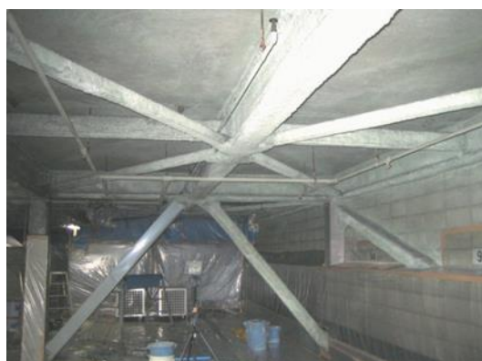
図 4.7.5 同上施工区画の内部側
