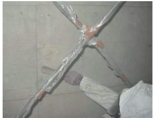
図 4.7.72 ワイヤブラシを用いた擦り落とし作業
