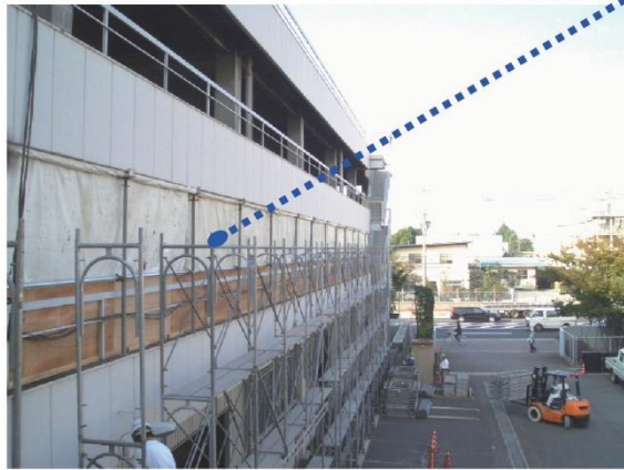
図 4.7.18 外壁開口部の飛散防止養生（既存手すりを活用し、防炎シートとベニヤ板を使用して負圧隔離養生の破損を防止）
