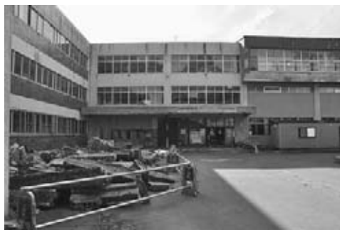
▲解体工事中の旧緑小学校
