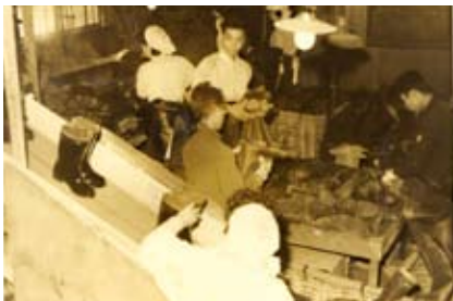
昭和40年ごろのゴム工場の様子
