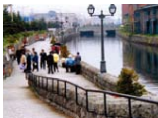
小樽運河スロープ手すり
