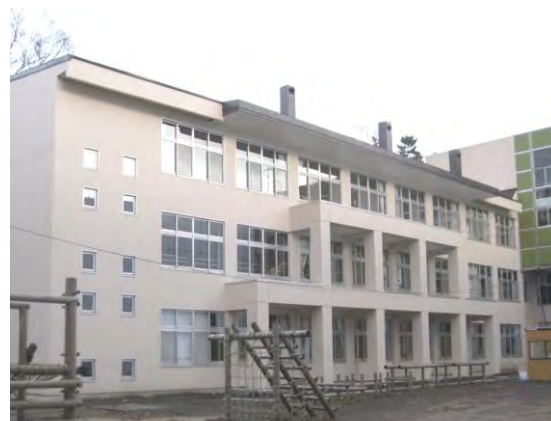
桜小の耐震補強工事 (平成 22 年 12 月完了)
