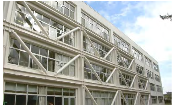
長橋小の耐震補強工事(平成22年12月完了) ブレースを斜めに入れ耐震補強工事を行いました。また、これに合わせて校舎の外壁・屋上防水の改修や暖房設備更新等も行いました。(屋上には太陽光パネルを設置)
