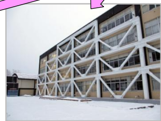
← 耐震補強工事を終えた校舎
