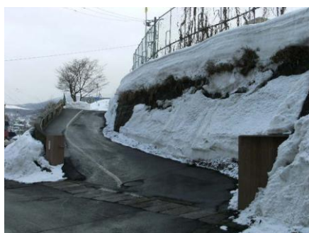
正門付近改修(幅員・歩車道分離・安全柵など)
