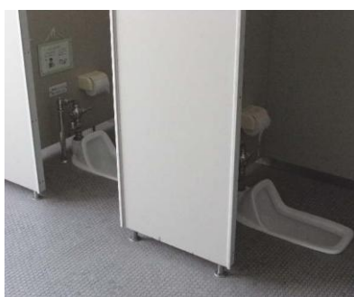
トイレ(洋式化・悪臭対策)
