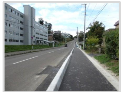
歩道が完成した市道桜1号線
