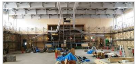
工事の様子(1月29日撮影)
