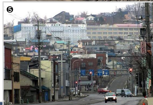
平成 26 年 4 月 3 日撮影 建設中の新校舎 (左上) と 現手宮小校舎 (右上)
