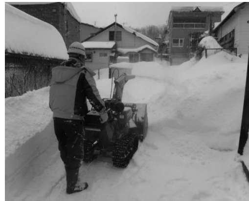
生活道路の小型除雪機を使用した除雪作業状況
