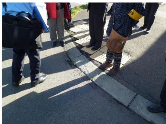
市道住吉線（交差点付近）
