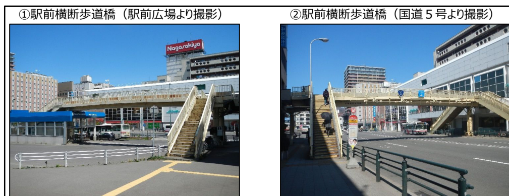
図 3-33 歩道橋の現状
