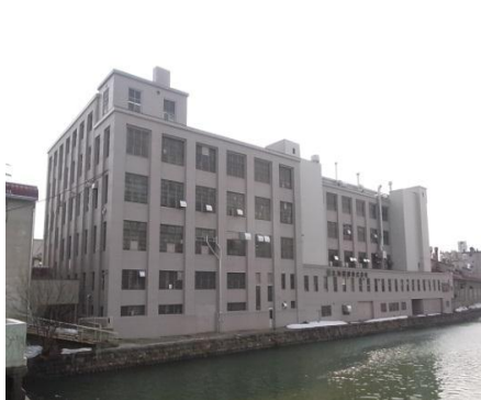
旧北海製罐倉庫(株) (北海製罐(株)小樽工場)
