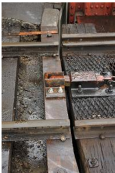
補修箇所（拡大）
