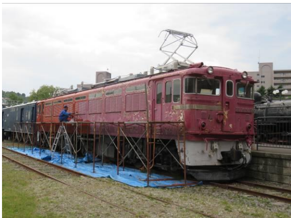
修復中の状況（電気機関車）
