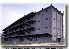
北海製罐小樽工場及び倉庫
