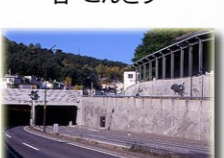
砂留トンネルの壁面レリーフ
