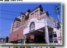
小樽開発ビルA棟
