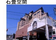
小樽開発ビルA棟
