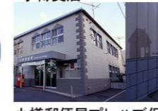
小樽郵便局プレハブ仮庁舎と仮囲いの歴史イラスト
