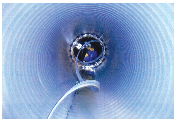
<下水管路の更新中>
