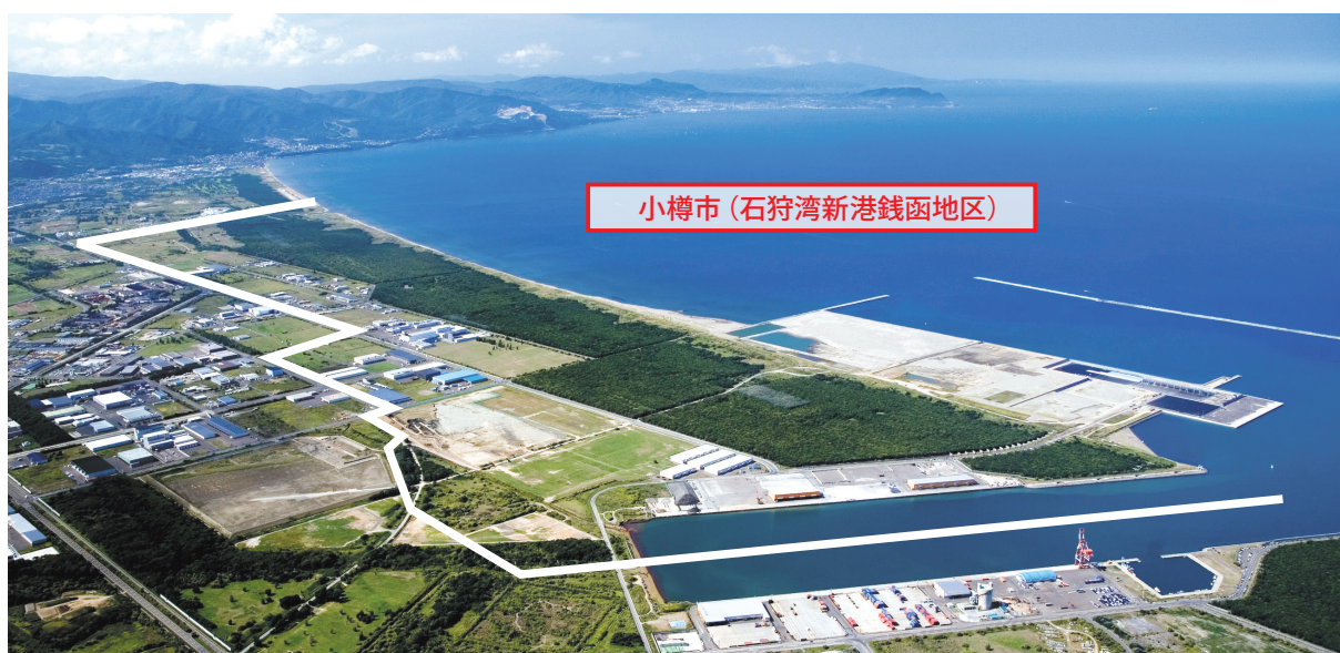
<小樽市（石狩湾新港銭函地区）>
