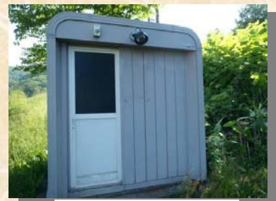
導水トンネル入口
