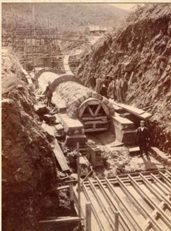
導水トンネルの建設
