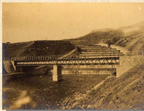
創設当時の階段式溢流路 いつりゅうろ
