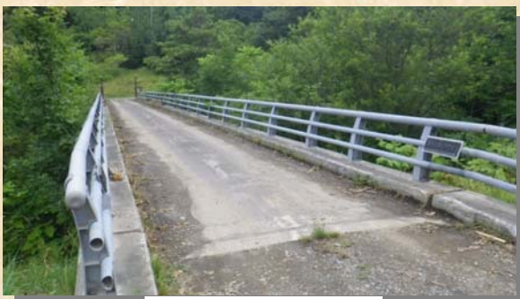
③放水路を渡河 する水源橋
