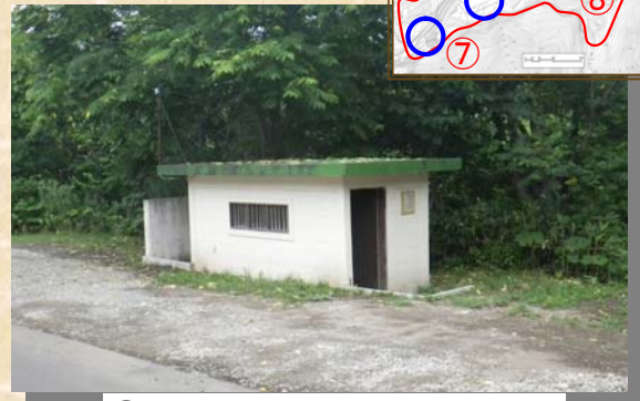
⑥水源地内広場にあるトイレ
