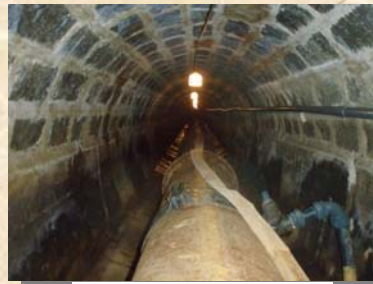
導水トンネル内部
