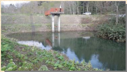
⑦勝納川からの引込口にある取水ゲート・樋門
