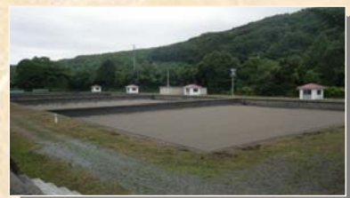
ろ過池(奥沢浄水場)
