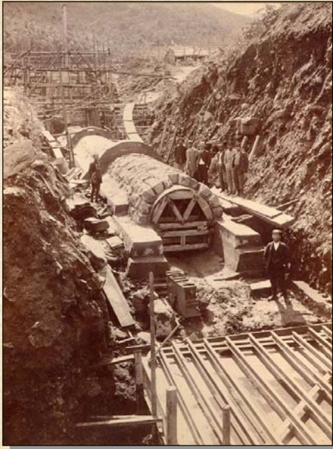
導水管隧道工事状況
