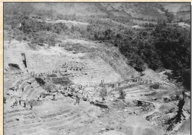
法面掘削状況
