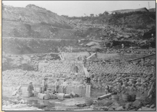
階段式溢流路工事状況
