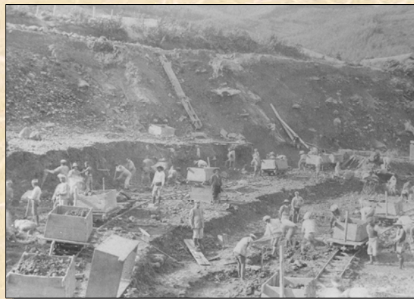
掘削土積み込み状況
