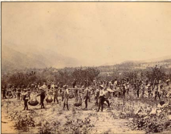
貯水池内掘削状況
