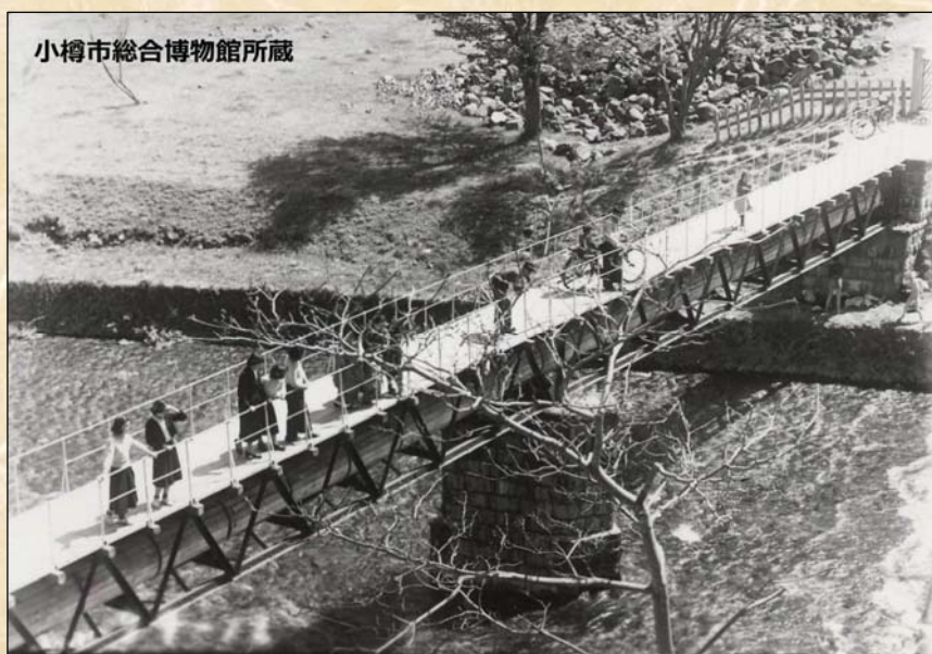
水管橋の利用状況
