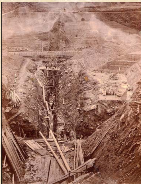
ダム堤心掘削工事状況
