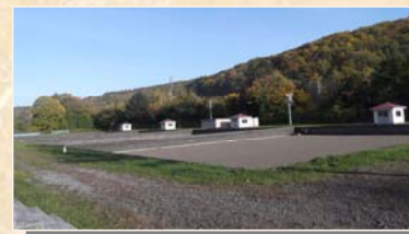
ろ過池(奥沢浄水場)
