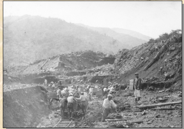
掘削土砂運搬状況
