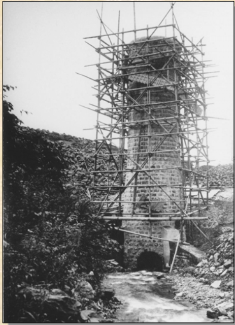
取水塔建造状況
