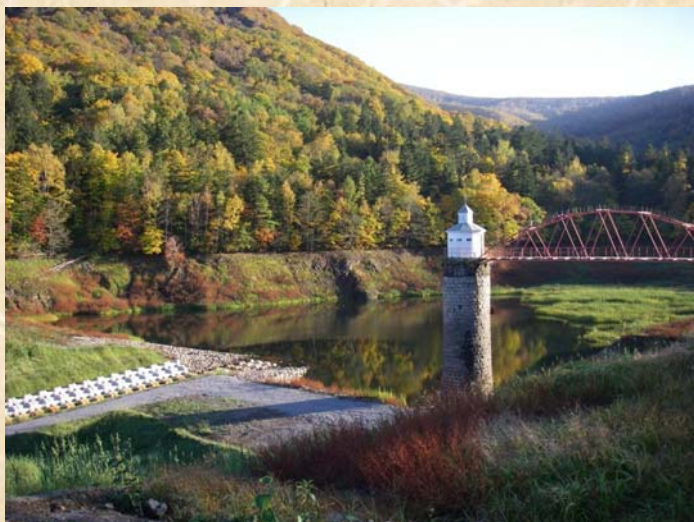
堤体からの眺め
