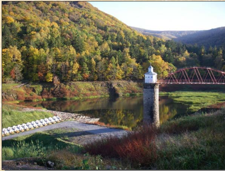
堤体からの眺め
