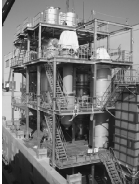
中央下水終末処理場 汚泥焼却設備設置状況
