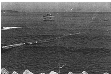
海底放流管布設工事
