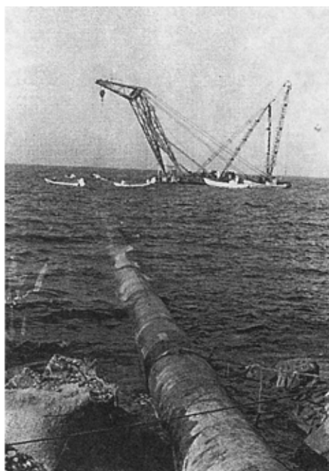
海底放流管布設工事
