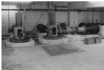
入船中継ポンプ場 汚水ポンプ
