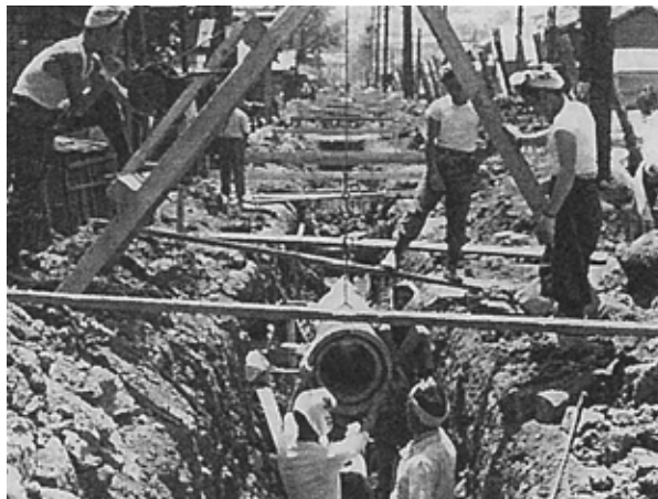
下水道管布設工事
