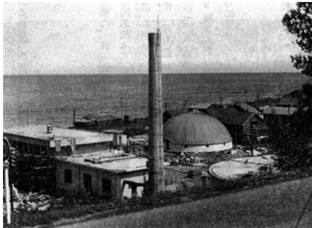
下水道工事状況
