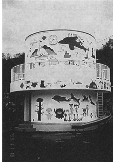
祝津中継ポンプ場
