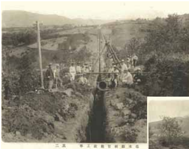
第1次拡張工事 導水管布設
