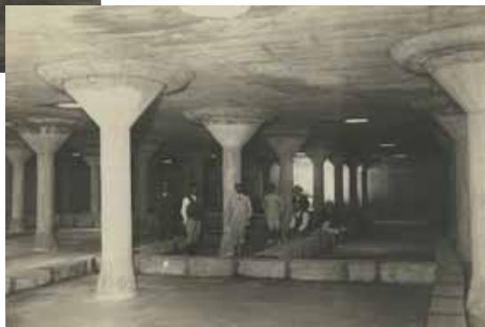
覆蓋式緩速ろ過池
