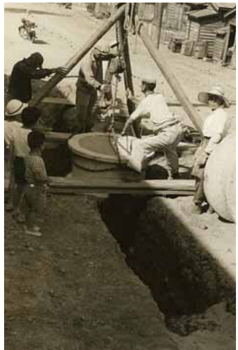
マンホール設置
