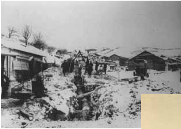
創設時 配水管布設
