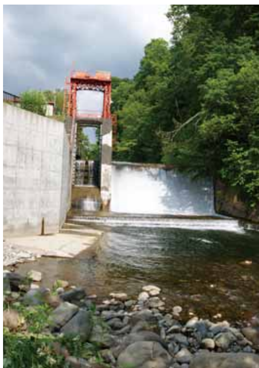
余市川 取水堰堤
