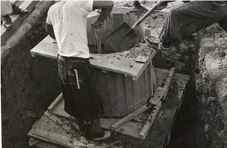
マンホールの基礎を造るため円形の型枠へスコップを使い、コンクリートを打設しています。
