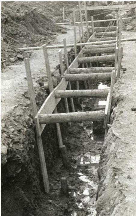
汚水管を敷設するため、土砂が崩れないように土留矢板を設置しています。
