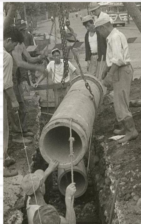
やぐらを使って汚水管を吊り下げ、管を敷設しています。
