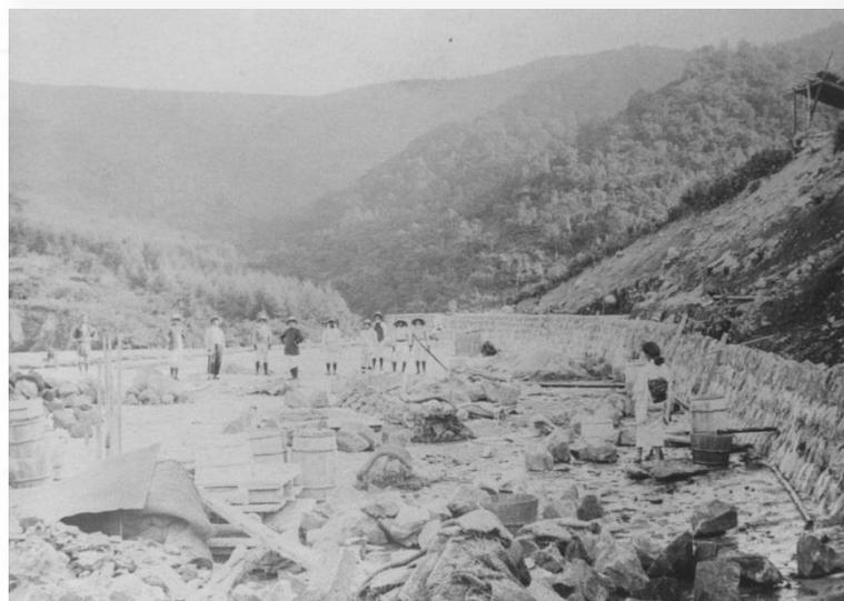
建設中の洪水吐(こうずいばき)の写真です。底面に石を張り、水路を造っています。
