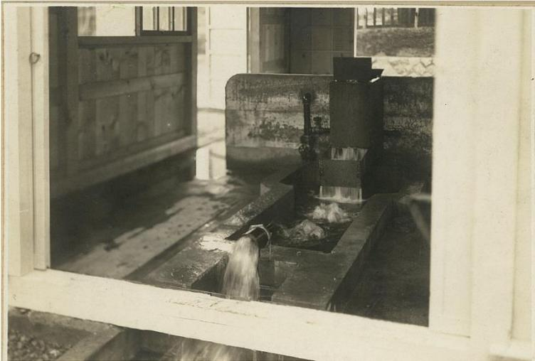
完成された潮見台浄水場の洗砂場の写真です。ろ過砂は洗砂しながら再利用していました。
