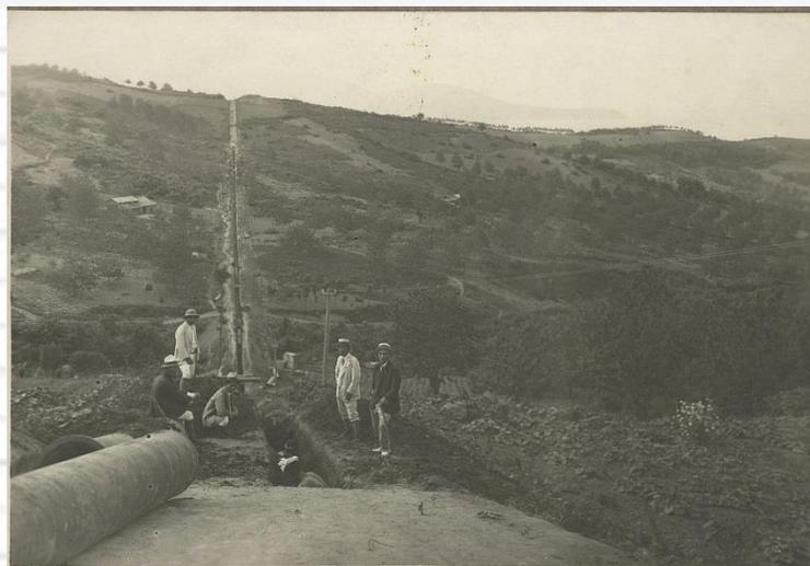
敷設中の導水管工事の写真です。起伏のある場所に一直線に敷設しています。
