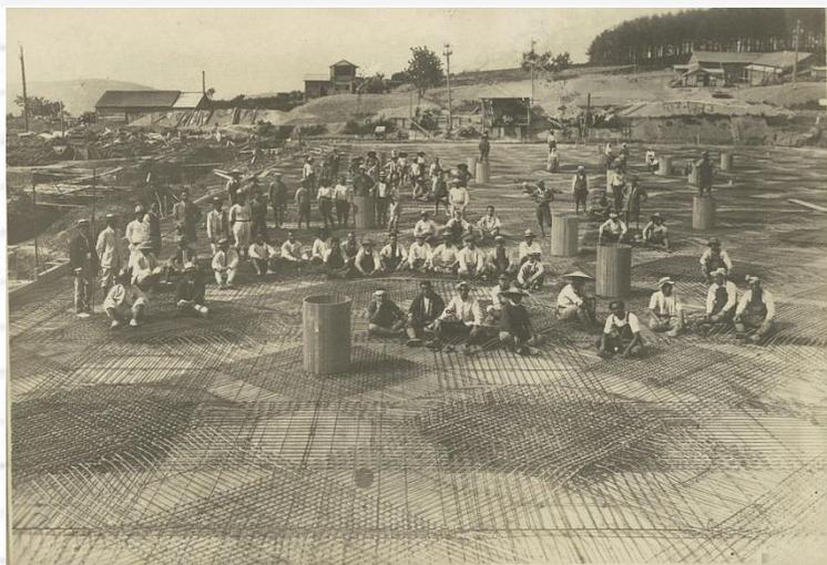
建設中のろ過地の写真です。ろ過地の底版に鉄筋を配置しています。
