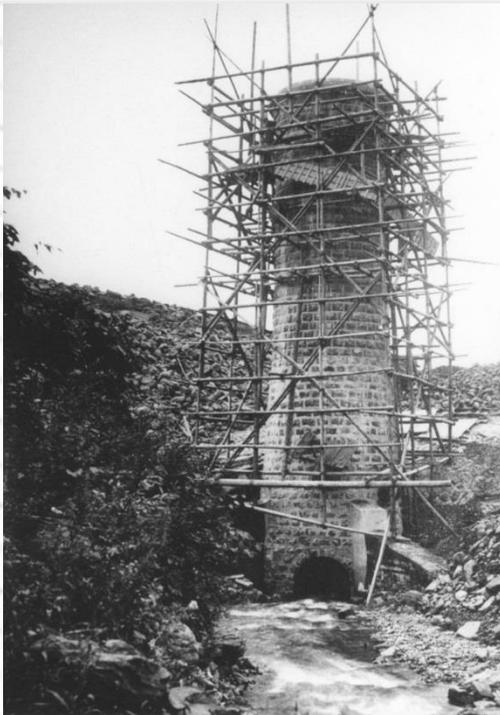
建設中の取水塔の写真です。写真下方の穴は、貯水池に流れ込む河川水を流すための仮水路の入口となっています。(明治45年撮影)
