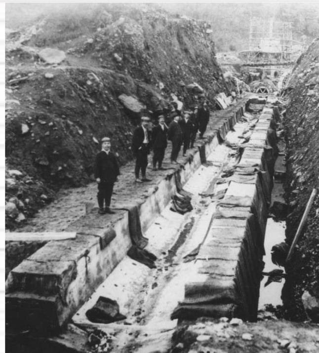
建設中の導水トンネルの写真です。導水トンネルの下部をコンクリートにより打設しています。また、布状のものでコンクリートの表面を養生しています。
