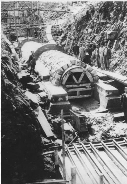
建設中の導水トンネルの写真です。導水トンネルの下部はコンクリート、上部は石組の構造となっています。
