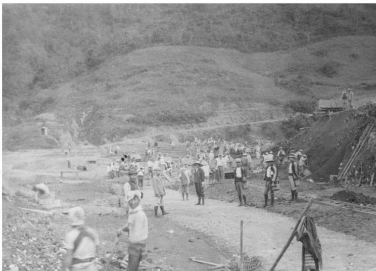
建設中の奥沢ダム堰堤(えんてい)の写真です。奥沢ダムの堰堤を造るため、トロッコなどを使い盛土作業をしています。
