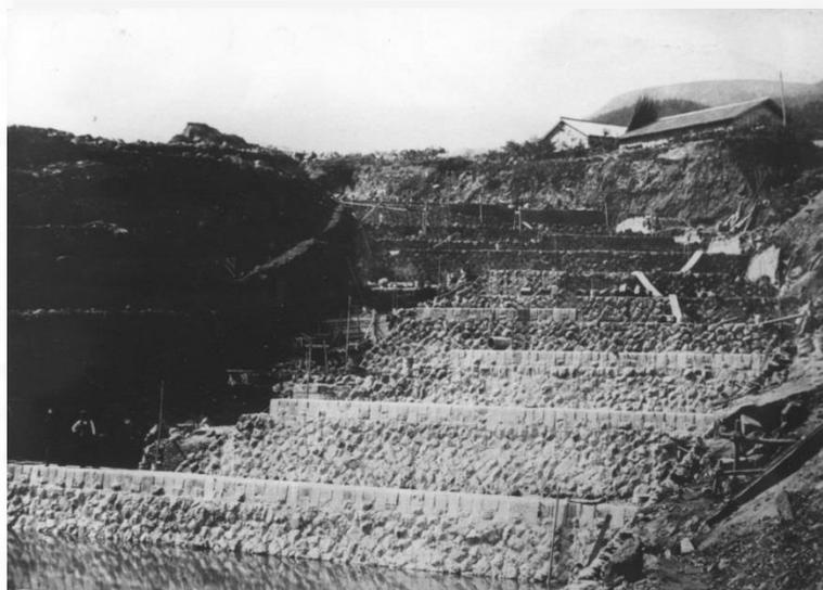
建設中の階段式溢流路(いつりゅうろ)の写真です。10段からなる階段式溢流路(いつりゅうろ)の上段部分を石積み、完成に近づいています。
