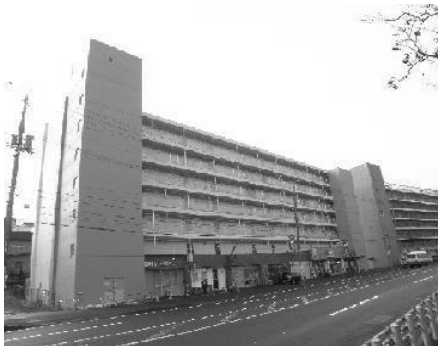
若竹住宅（全面的改善を実施）
