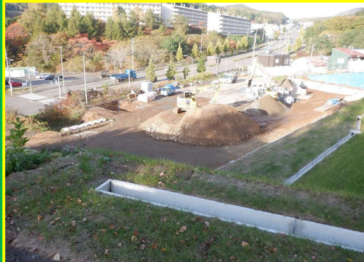
＜建設位置の背面余市側から撮影＞
