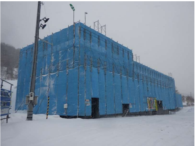
塩谷B住宅建替工事の状況（R7.12月）
