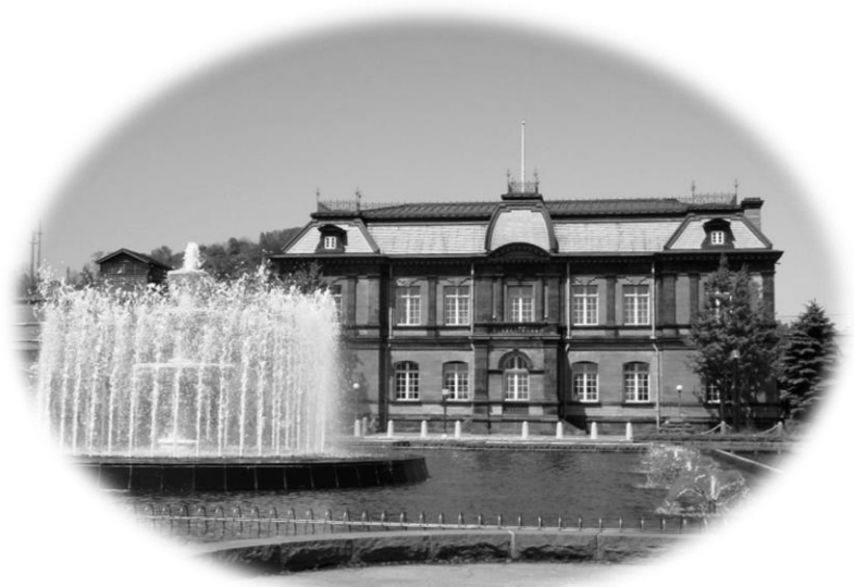
運河公園と旧日本郵船(株)小樽支店
