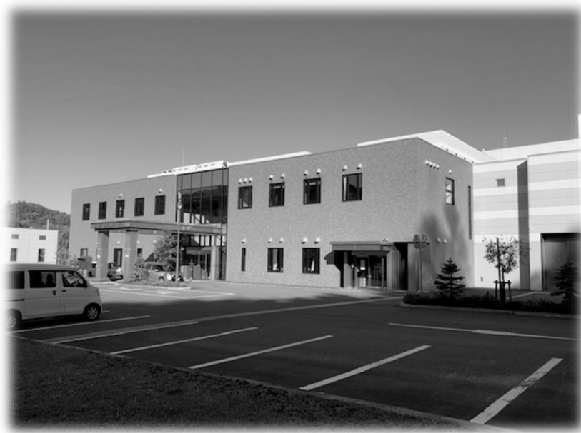
北しりべし広域クリーンセンター
