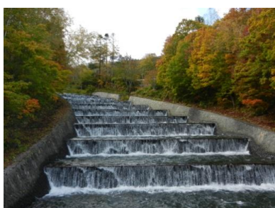
奥沢水源地（階段式溢流路）
