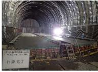
ニセコトンネル 長尺先受工 13シフト施工状況
