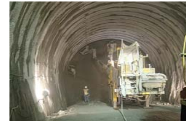
ニツ森トンネル(尾根内) トンネル掘削作業状況
