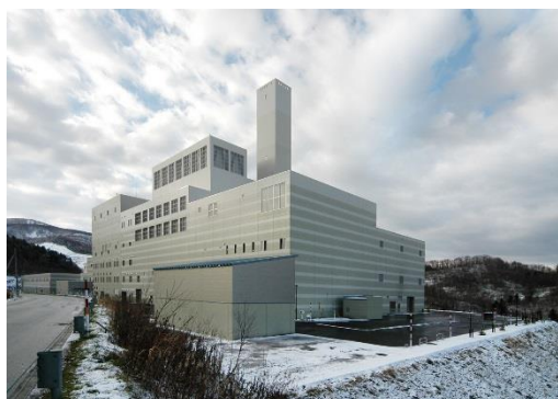
【北しりべし広域クリーンセンター】
