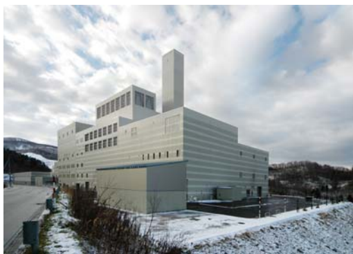
【北しりべし広域クリーンセンター】
