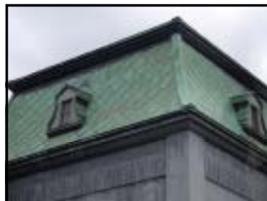
ドーマーの事例
