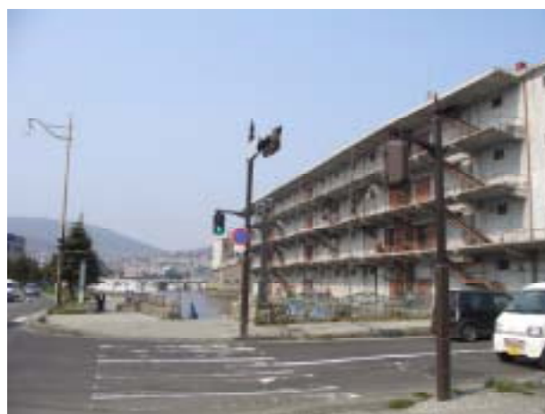
北運河と周辺の工場施設
