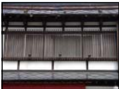
こうし 格子窓の事例
