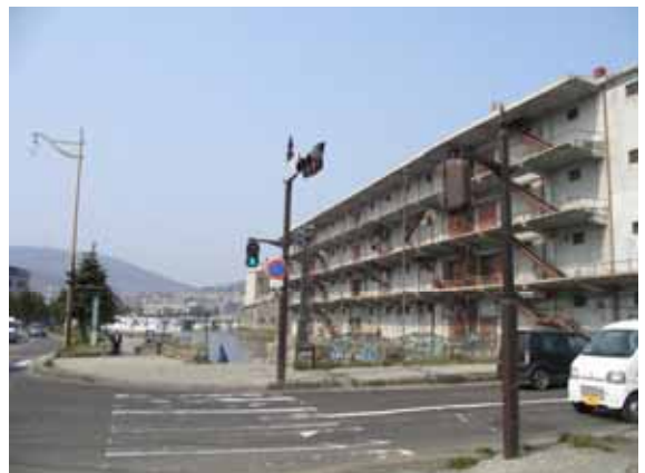
北運河と周辺の工場施設
