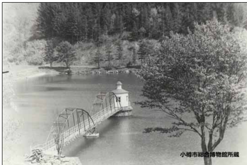
《創設当時の奥沢水源地》
