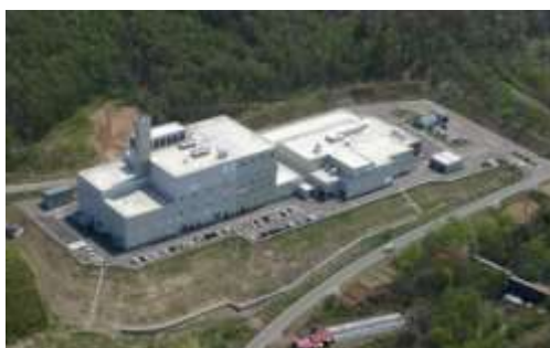
北しりべし広域クリーンセンター
