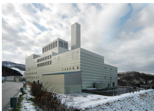
【北しりべし広域クリーンセンター】
