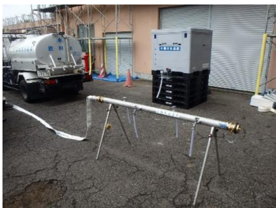
＜応急用給水栓＞
