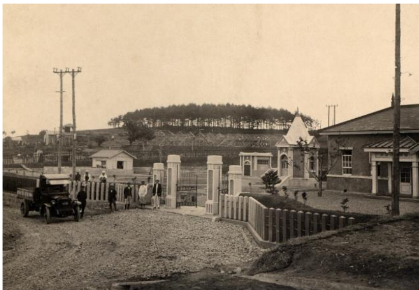
<建設当時の潮見台浄水場 大正 15 年 7 月撮影>
