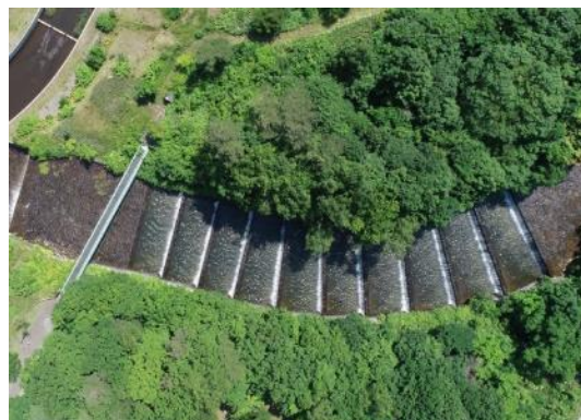
<上空から見た奥沢水源地階段式溢流路>
