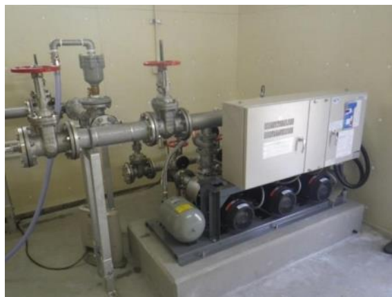
〈インバータ制御による配水ポンプ〉
