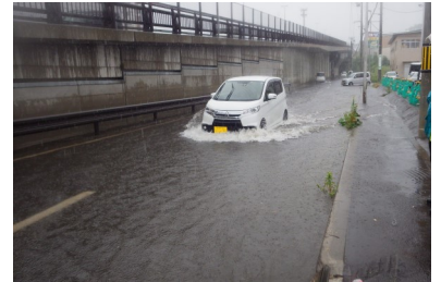
小樽IC臨港線出口 2017(H29)年7月 大雨による道路冠水
